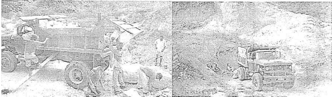
Foto N° 3 – N°4. Fecha: 03 de Agosto de 2017. Ubicación: Canteras de Colombia S.A. (Titulo Minero N°10429), Vía Cordialidad (Km 53 + 400), Luruaco - Corregimiento de Arroyo Piedra/Atlántico. Observaciones: Cargue de material explotado.
